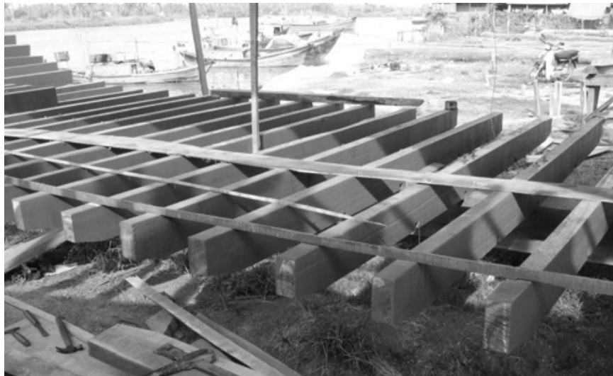
Hình 1.6.2. Đáy một tàu gỗ thật đang thi công
