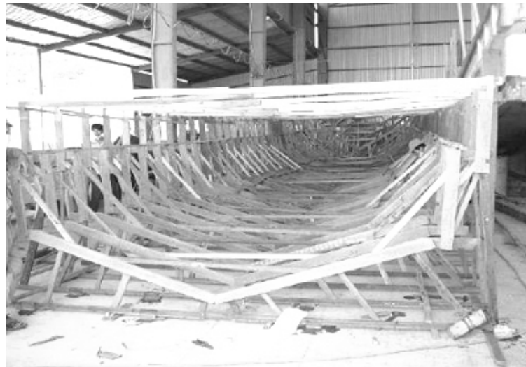
Hình 2. Gia công khuôn
