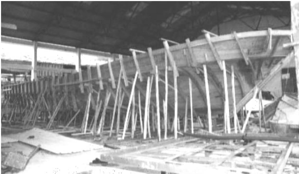
Hình 3. Khuôn tàu (bằng gỗ)
